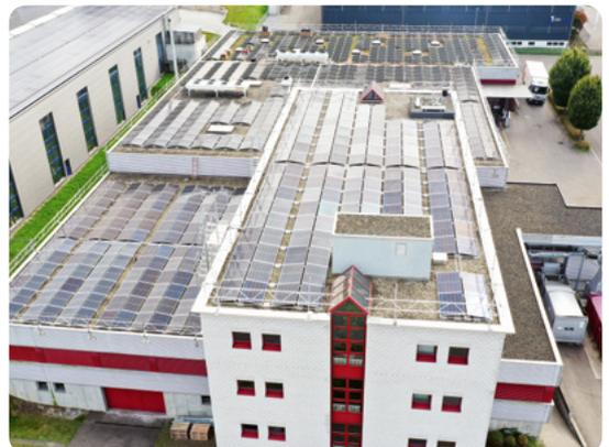
Am Standort Flawil stehen die Arbeiten an der Photovoltaikanlage auf dem Dach des Verwaltungs- und Produktionsgebäudes kurz vor dem Abschluss: Die insgesamt 978 Module sind montiert und die Leitungen verlegt.
